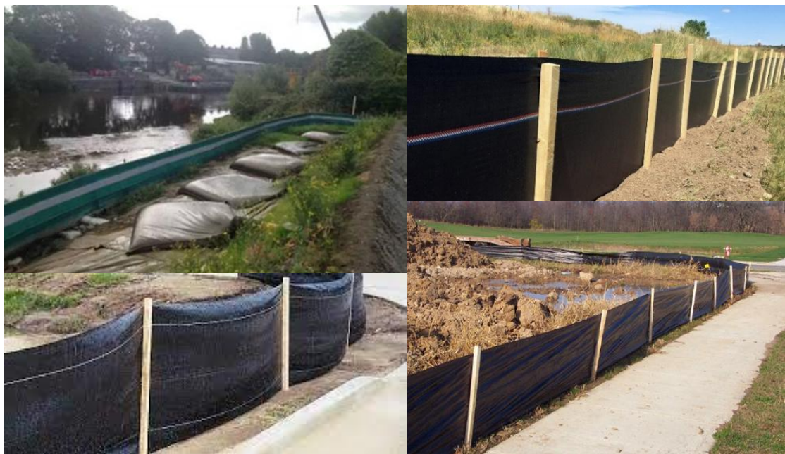
รูปที่ 6.2-5 ตัวอย่างรั้วดักตะกอนชั่วคราวแบบ Temporary Silt Fence
