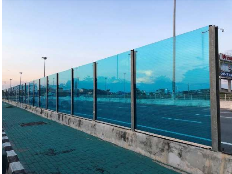
รูปที่ 6.2-13 ตัวอย่างลักษณะการติดตั้งกำแพงกันเสียงถาวร
