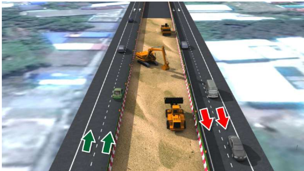
รูปที่ 6.2-26 ตัวอย่างการจัดจราจรในระหว่างการก่อสร้างขยายทางหลวง ระยะที่ 2
