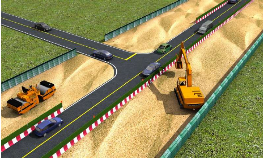
รูปที่ 6.2-25 ตัวอย่างการจัดจราจรในระหว่างการก่อสร้างขยายทางหลวง ระยะที่ 1 (ต่อ)
