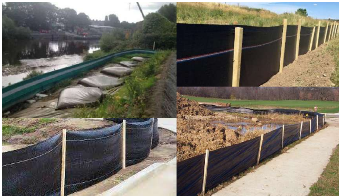
รูปที่ 5.3.1-7 ตัวอย่างรั้วดักตะกอนชั่วคราวแบบ Temporary Silt Fence
