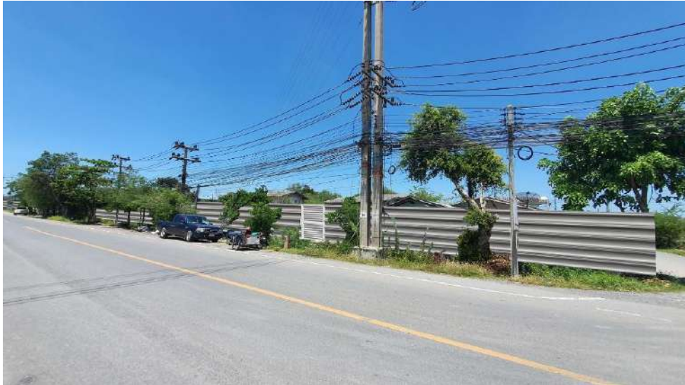
รูปที่ 6.2-10 ตัวอย่างการติดตั้งกำแพงกันเสียงชั่วคราว
