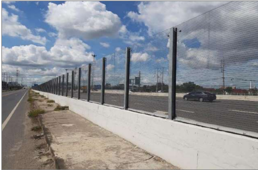
รูปที่ 5.3.1-11 ตัวอย่างลักษณะการติดตั้งกำแพงกันเสียงถาวร
