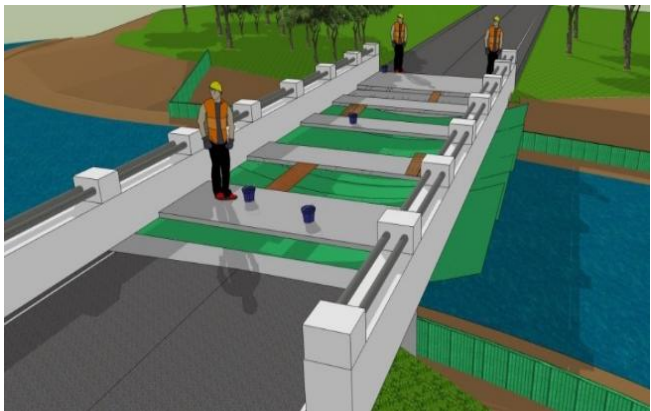
ติดผ้าใบได้โครงสร้างสะพานข้ามแหล่งน้ำ
