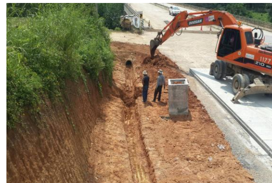
ติดตั้งบ่อดักตะกอนชั่วคราว
