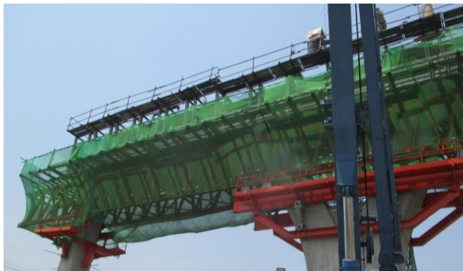
ติดผ้าใบได้โครงสร้างสะพานข้ามทางหลวงชนบท นค.1017
