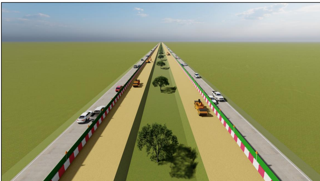
รูปที่ 6-10 การจัดจราจรในระหว่างการก่อสร้างขยายทางหลวงหมายเลข 2 ระยะที่ 2
