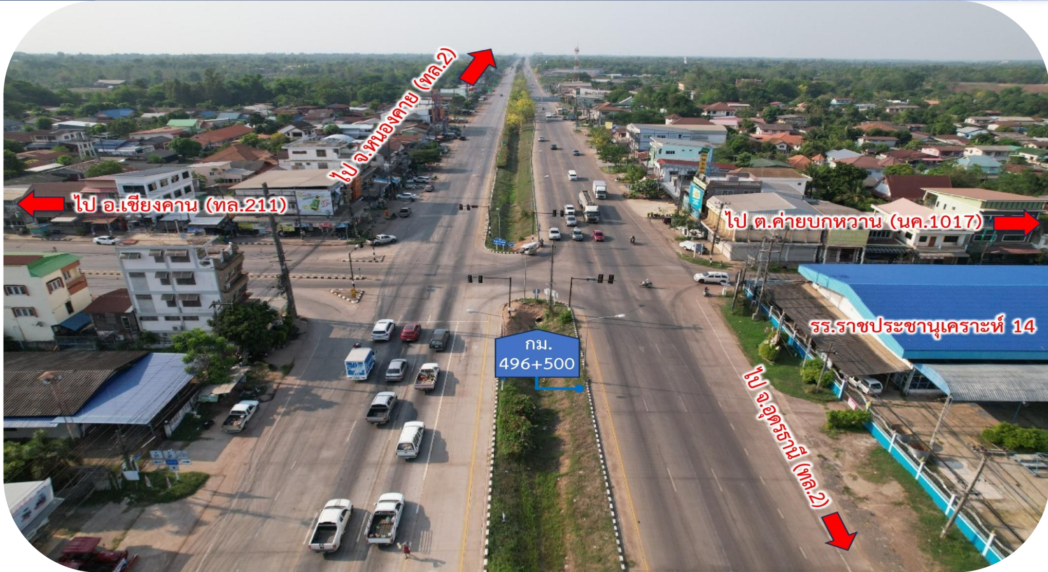
สภาพปัจจุบันบริเวณทางแยกหนองสองห้อง
