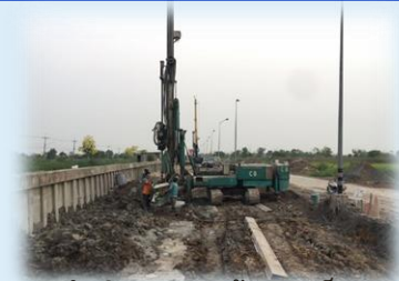
ดำเนินงานก่อสร้างเสาเข็ม ในเวลากลางวัน (08.00-17.00 น.)
